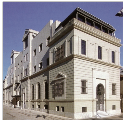
Εικόνα 2. Το κτίριο της Βιβλιοθήκης του Πανεπιστημίου (Βόλος)
