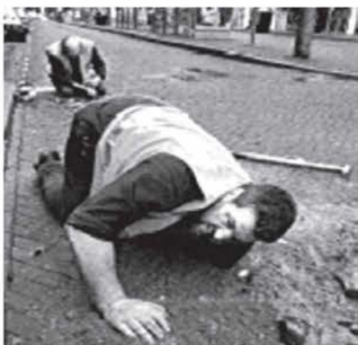
Σχήμα 4: Σκάψιμο με το χέρι προς αποφυγή ζημιάς στην καλωδιακή υποδομή
